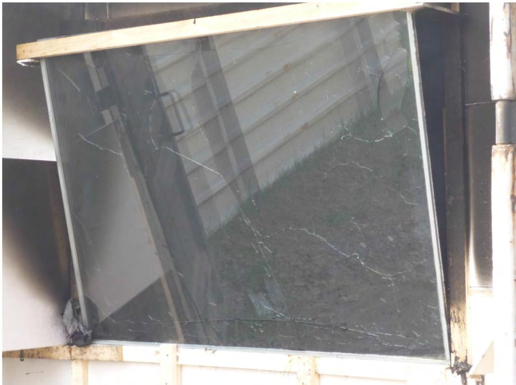
**Abbildung 33: Foto des südlichen gekippten Fensters mit den charakteristischen Sprüngen**
